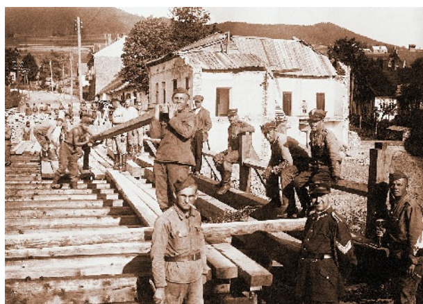
Odbudowa mostu po wielkiej powodzi – lato 1934 roku.
