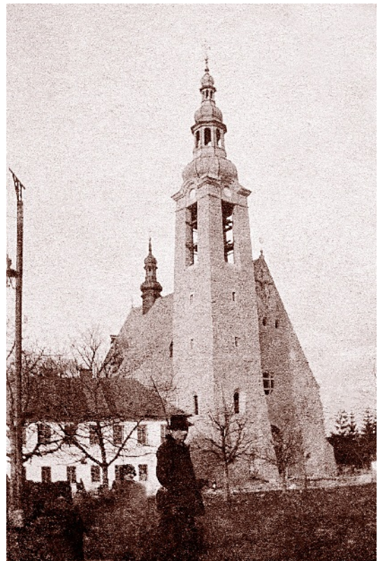
Końcowy etap budowy kościoła – pomnika Konstytucji 3 Maja, poświęconego 6 października 1918 roku.
