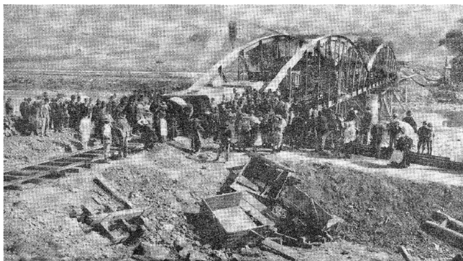
Odbudowa mostu kolejowego.
