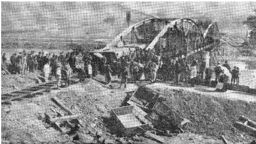
Stavba železničného mosta.
