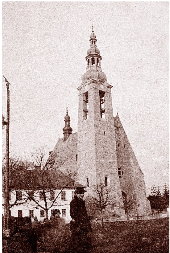
Záverečná etapa výstavby kostola – pomníka Ústavy 3. mája, vysväteného 6. októbra 1918.
